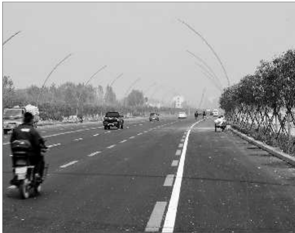
升级改造之后的火炬路景观大道焕然一新。 刘守善 摄
