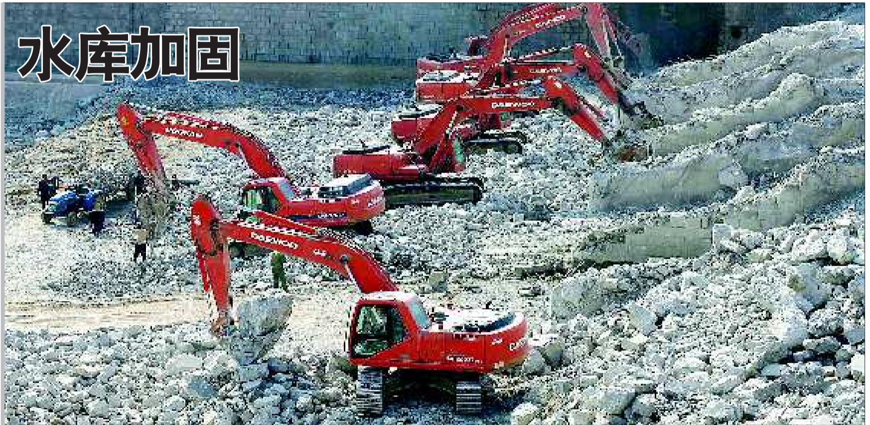
7日,烟台市福山区门楼水库,挖掘机组正在紧张地施工中,历经半个世纪沧桑门楼水库存在抗震和防洪标准低、大坝渗漏等问题,已被列入“全国重点病险库”,改造后的门楼水库,其抗震级别从6级提高到7级,对洪水的调控能力将大大加强,居民用水、保证耕地用水等方面都会得到更加安全的保障。 本报记者 赵金阳 摄
