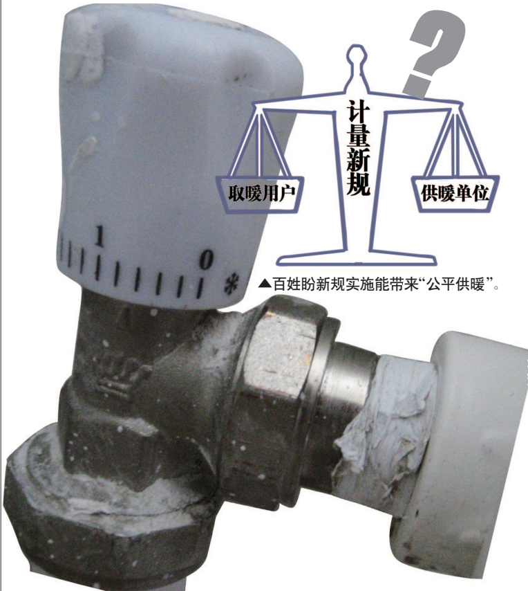
▲通过可控阀门,取暖用户可对供热量进行调节。
