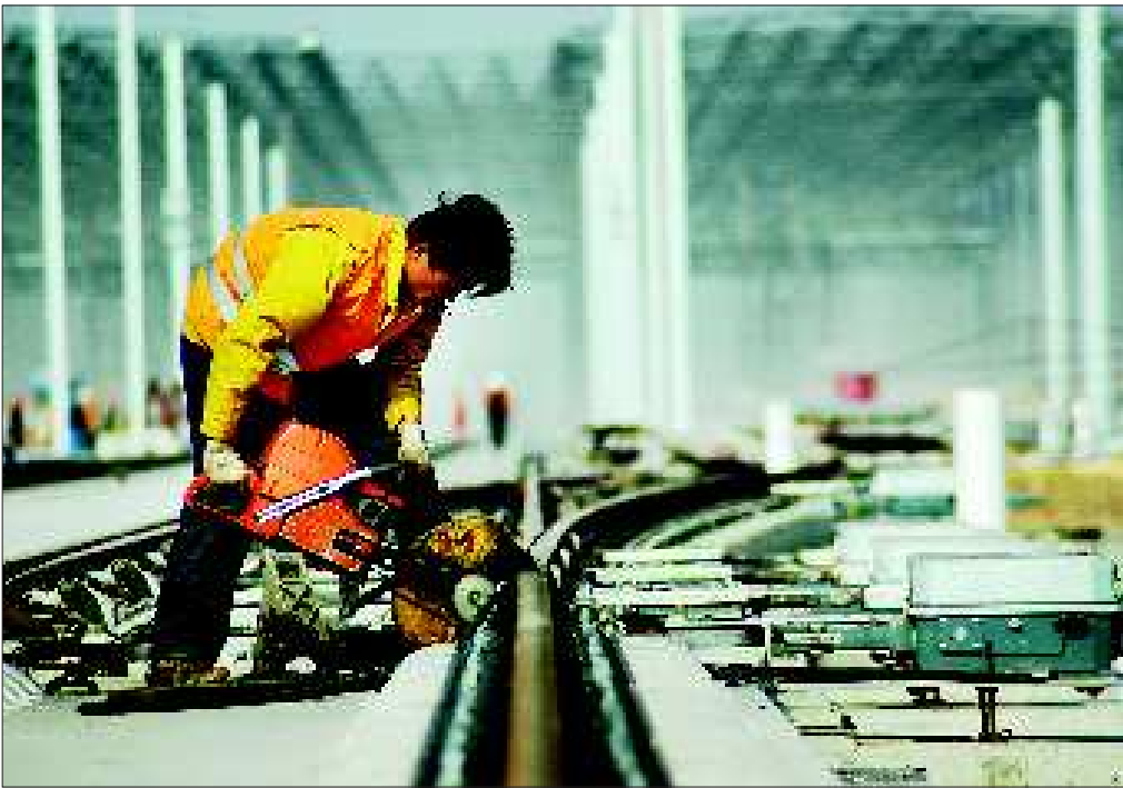
施工人员正对道岔和正线间的接缝进行“铝热焊”。 本报记者 马志勇 摄
