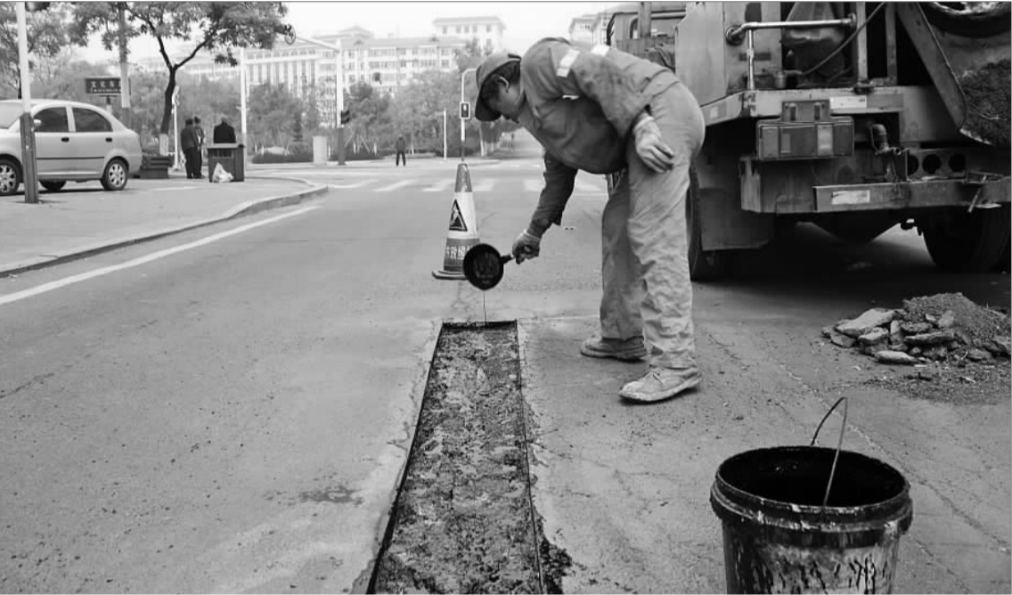
补路 7日下午，威海威畅市政工程施工维护中心在纪念路上修补损毁路面，据现场工作人员介绍，随着冬天到来，天气越来越冷，要及时进行冻前整修，否则届时路面病害会更加严重。 本报记者 侯书楠 摄
