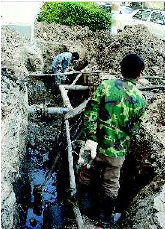
黄屯小区供暖管道正在抢修。本报记者 师文静 摄
