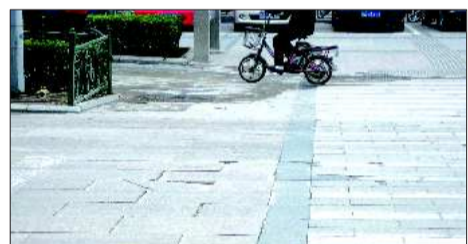
9日上午,泉城路商业街水水马龙,石板路面存在不同程度的损坏现象。泉城路与天地坛街交叉路口的斑马线位置损毁较为严重,路面石板有的破损、有的已经断裂,每当大型车辆驶过便会发出咯嗒咯嗒的声响。 本报见习记者 王若松 摄
