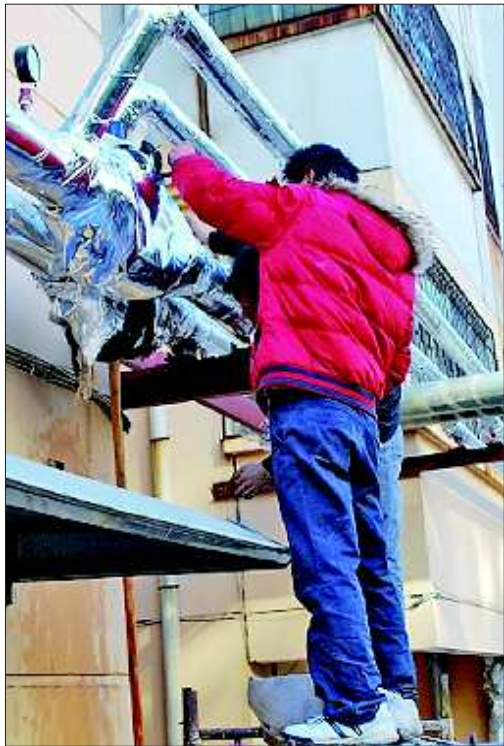
明珠花园小区祥和园,工作人员正在维修供热管道。
