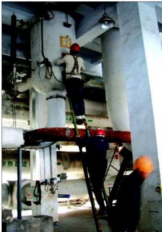
▲蓝天热力有限公司的工作人员正在对机器进行检修。
