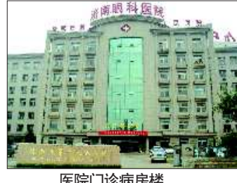
医院门诊病房楼
