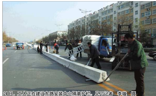
24日,工人正在建设东路安装中心隔离护栏。见习记者 李璇 摄
