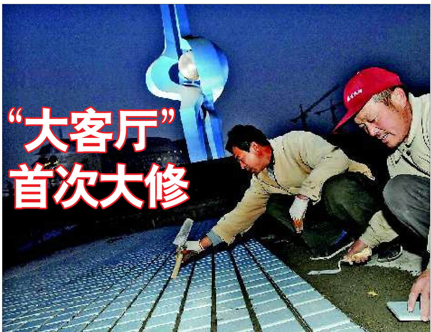
29日,泉城广场管理处开始对广场进行全面整修,这次整修投资近100万元,主要对广场的大理石地面、树穴及沉降处进行修缮。此次整修是“大客厅”12年来首次大规模的彻底整修。施工期间广场正常开放。图为29日晚,来自泰安的技术工人在泉标南侧铺设新的广场砖。
