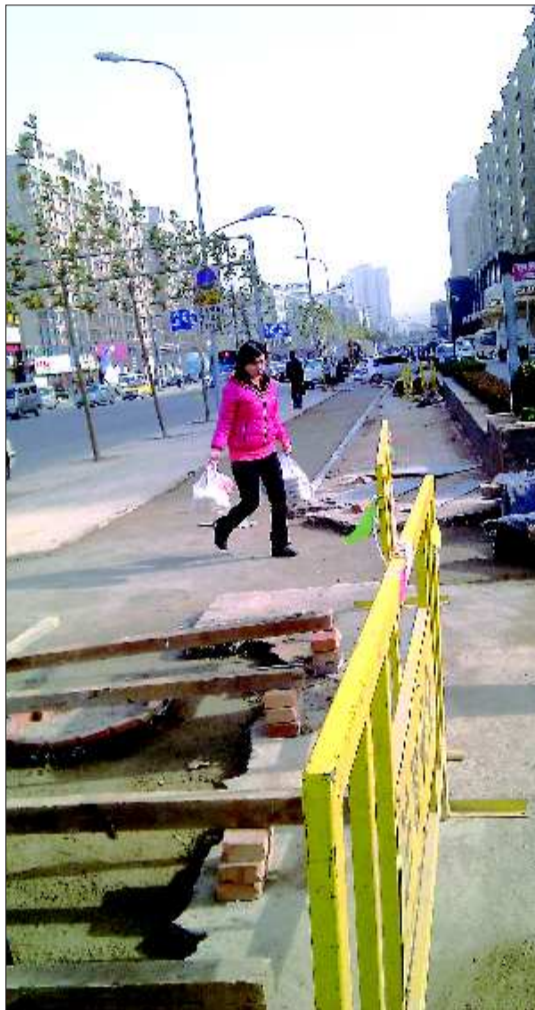
供暖管道的施工已经完成。见习记者 任志方 摄
