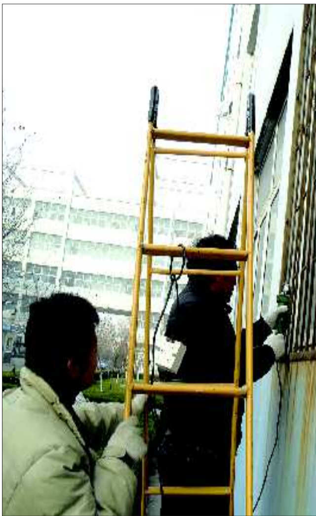
工人师傅正在拆除一楼的防盗窗。 本报见习记者 李金金 摄
