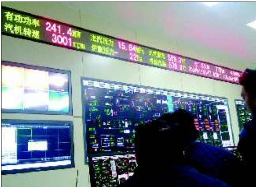
9号机组已开始试运行,监控大屏幕上显示主控温度568.3摄氏度。
