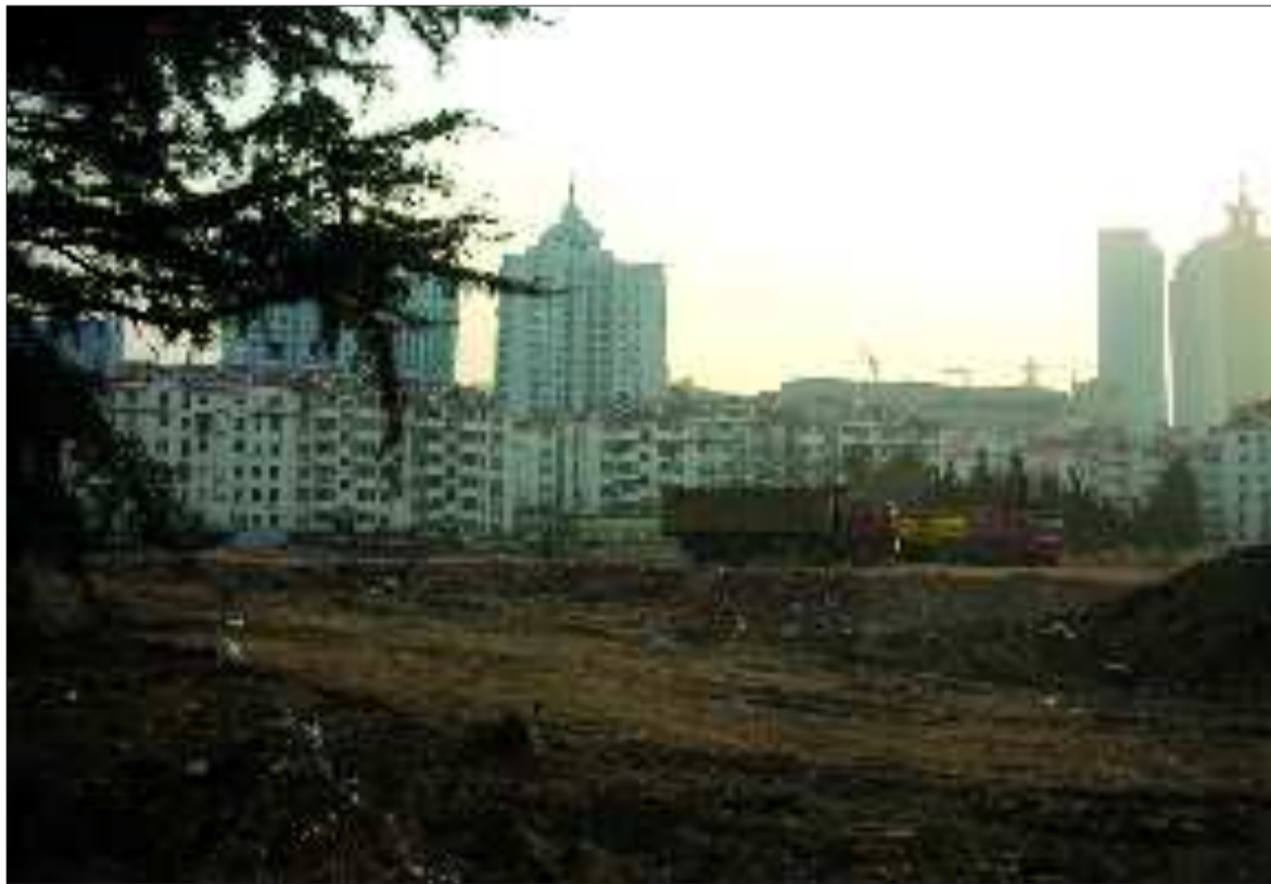
位于市区繁华路段的工人疗养地块土石方工程已开始施工。本报记者 宋珊珊 摄
