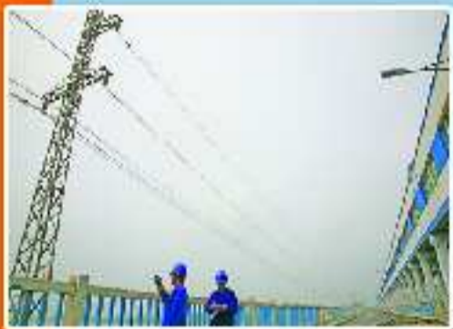
用测高仪测量跨湖线路对地距离。
