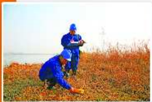
用红外线测温仪测量二级坝跨湖线路健康状况。
