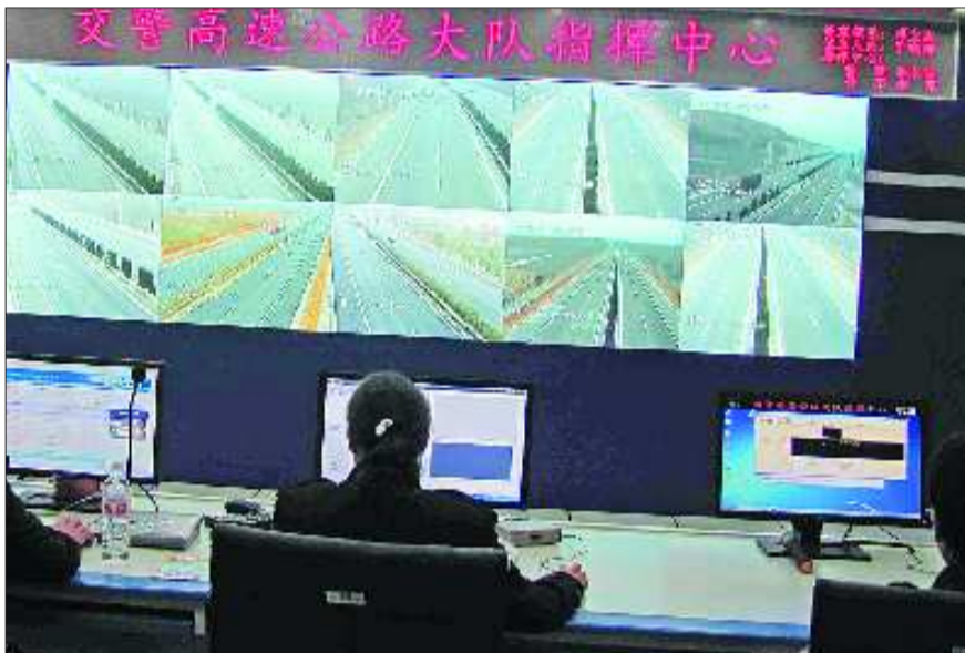
日照高速公路交警大队指挥中心正在对监控进行调适。
