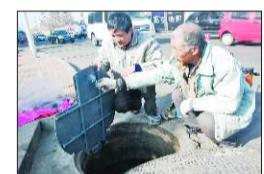
28日,在黄海二路一处管道口,一家通信公司的管线中心工作人员正在进行防盗井盖改造。工作人员在普通井盖的下面加上一层,并且用锁锁住,防止电缆被偷,同时也能保证万一上层井盖被偷后市民的出行安全,不会增加原来路面的井盖高度。目前正在试点,如效果好,将在全市推广。
