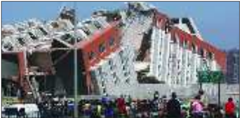
智利地震后的房屋。
