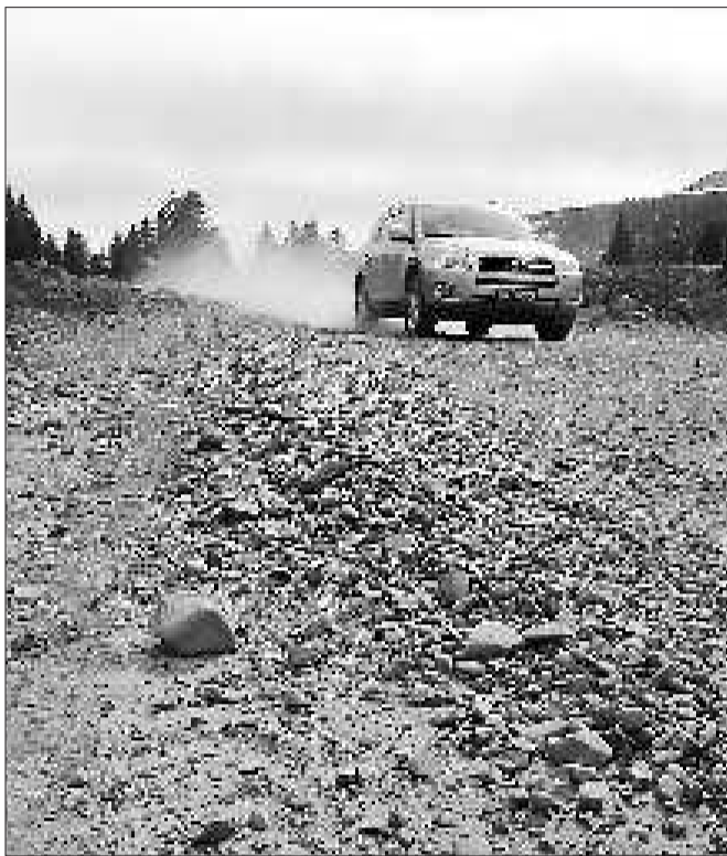
从新都桥开始,川藏公路因拓宽工程,路面上全是碎石。 本报特派记者 高洪超 摄
