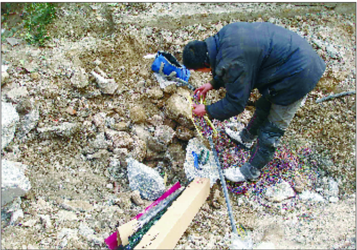
联通工作人员正在抢修电缆。
