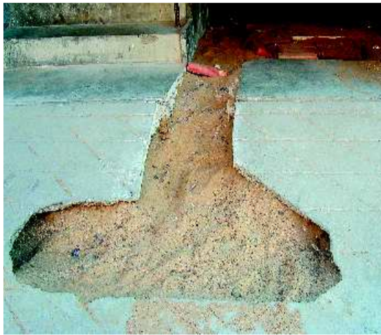
▲楼道口回填的路面向里延伸。
