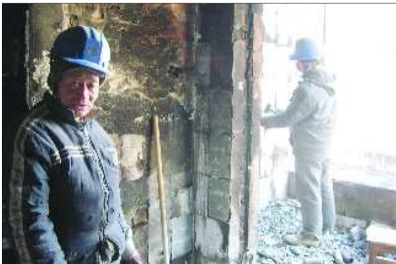
施工单位正在清理火灾居民楼。 吴金彪 摄
