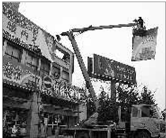
为了拒绝视觉污染,有业户正对户外广告自行拆除。
