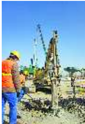
鹊华水厂内,工人正在打桩。见习记者 孟敏 摄
