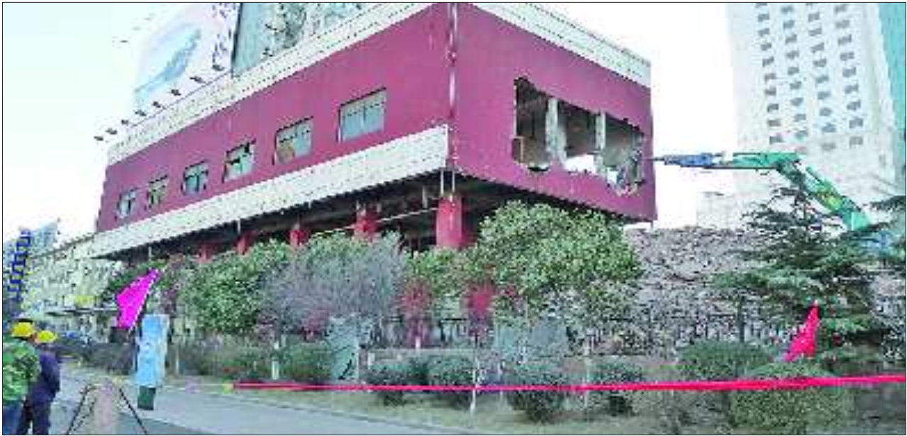
齐鲁宾馆老楼的爆破已经进入倒计时!1月23日下午,为配合即将进行的齐鲁宾馆爆破,宾馆东北侧的红色配楼也于当日拆除。楼前经十路人行道上拉起了封锁线,并立起了“施工危险,禁止停车”的牌子。“一千多个炸药孔已经打完,很快就要安装炸药。”施工人员表示。 本报记者 李飞 摄影报道
