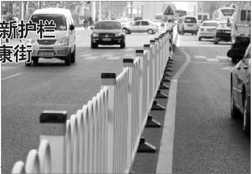
24日，潍坊市健康街（北海路至春鸢路段）新护栏已经安装完毕。据悉，潍坊市交警支队设施大队于1月10日开始，对健康街（北海路至春鸢路段）共5200米的道路隔离栏进行更换，新护栏加装了反光材料，安全性较原有护栏大大提高。
