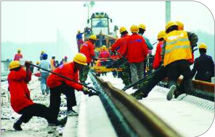
▲2010年10月,京沪高铁德州段铺轨。(资料片) 本报记者 马志勇 摄
