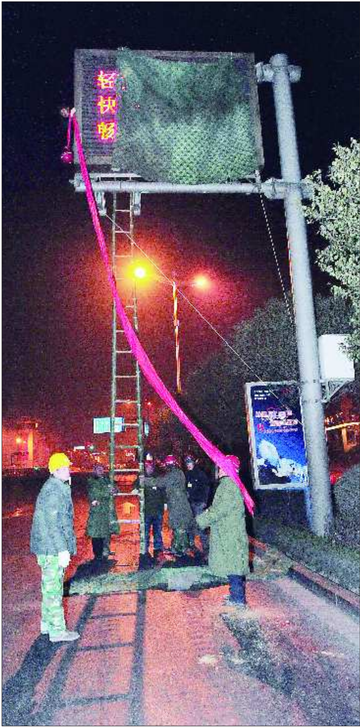
28日早上5点多,齐鲁宾馆爆破之前,施工人员将旁边经十路上的电子指示牌进行保护性围挡。 本报记者 邱志强 王媛 摄
