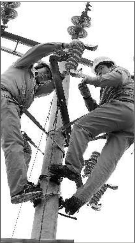
在菏泽东明县黄河滩区，村子在黄河东，黄河西的麦田没有电力线路，柴油水泵又够不着，三个村1万多亩地守着黄河水却用不上。菏泽供电公司接到村民求助后，连夜建设了3公里的临时灌溉线路，解决了村民的浇地难题。 本报记者 陈文进 杨传忠 摄影报道
