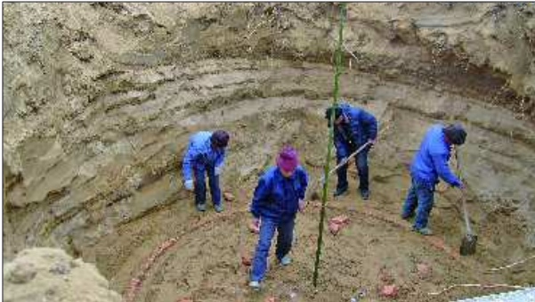
2月16日,高旺村沉盘井应急水源工程施工现场。
