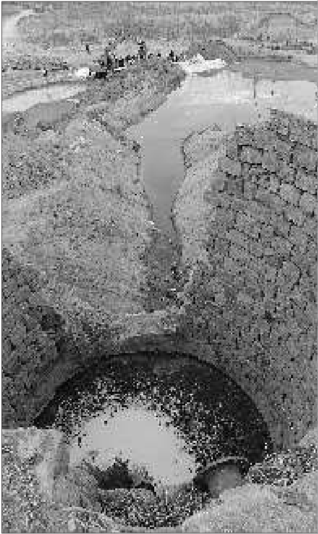
为了实施山区水源工程，邹城市张庄镇组织村民修筑拦水坝。 本报记者 黄广华 摄
