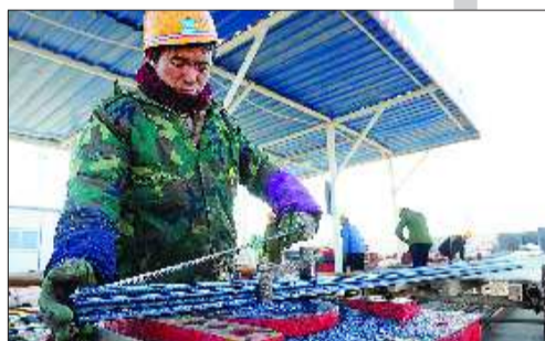
钢筋定型工人在认真作业。
