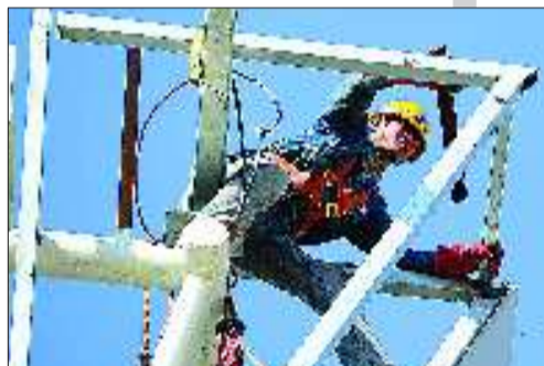
一位工人在高空焊接。
