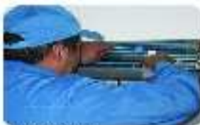
步骤4: 清洗室内机, 清除空调室内机蒸发器。
