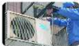
步骤5: 清洗室外机散热器, 清除室外机散热器。
