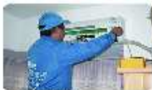
步骤2: 拆下空调挂板, 取出空调过滤网, 取出空调挂板。
