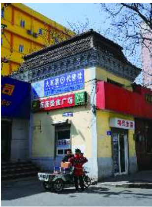
大观园的早期德式建筑配电室
