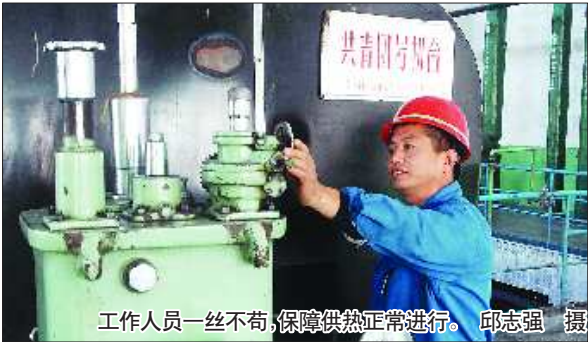
工作人员一丝不苟,保障供热正常进行。 邱志强 摄
