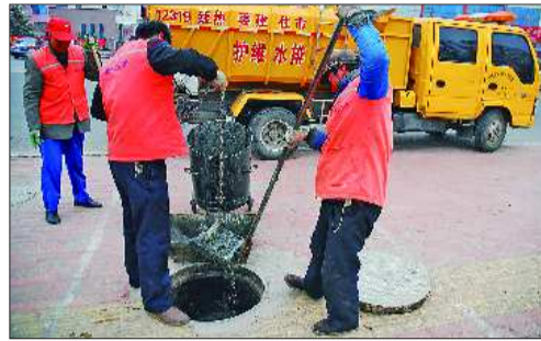
排水维护组队员正在对城区排水主管网进行清淤作业。 本报见习记者 张照朋 摄
