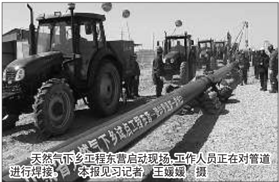
天然气下乡工程东营启动现场,工作人员正在对管道进行焊接。 本报见习记者 王媛媛 摄 本报3月29日讯(见习记者 王媛媛) 东营至潍坊天然气管线工程在东营正式开工建设,这标志着山东省的天然气下乡试点工作正式启动。 28日上午,山东省重点建设项目——东营至潍坊天然气管线工程在东营正式开工建设。据了解,东营——潍坊天然气管线是我省重点工程泰安、青岛、威海天然气管线的重要组成部分,是实施天然气下乡试点工作的基础。工程项目总投资约8亿元,全长近400公里,主管线设计管
