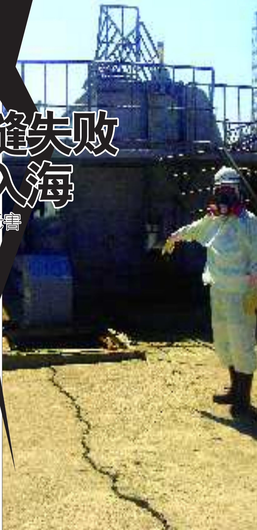
4月2日,抢险人员在2号机组反应堆裂缝前。 东方IC供图
