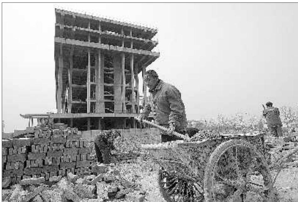
▲随着资金到位,山东轻工业学院图书馆重新开始施工。
