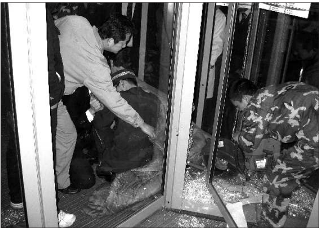
旋转门的玻璃被打碎,消防队员正在用电锯锯旋转门。 本报记者 赵波 摄
