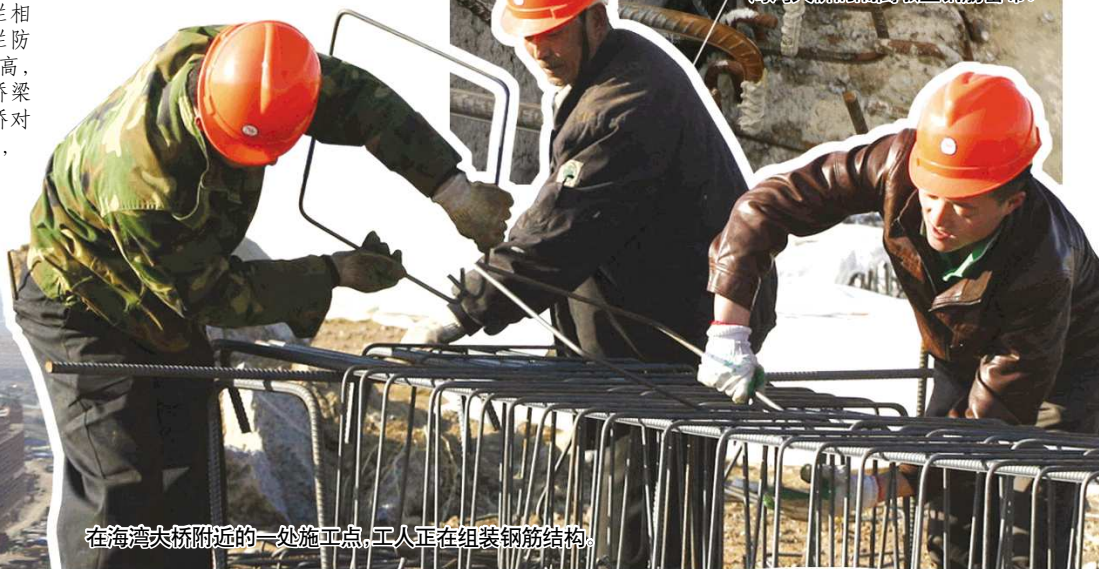
海湾大桥的隔离墩里钢筋密布。
