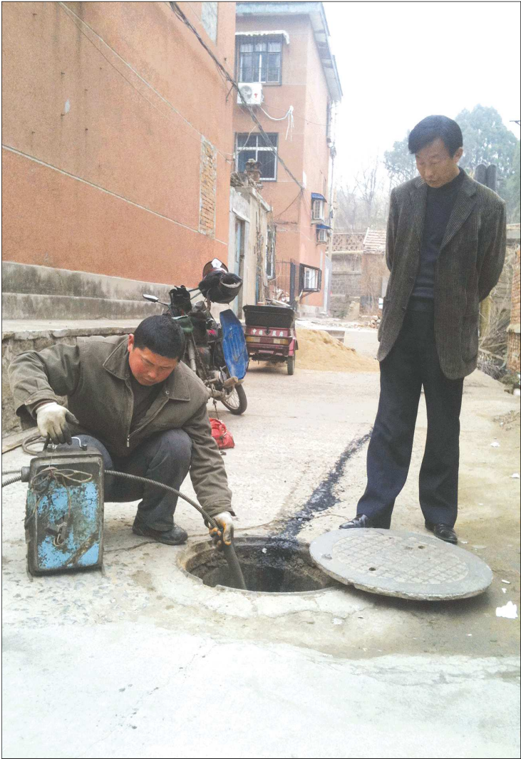
管道维修公司工人正在尝试着疏通下水管道。 本报记者 刘慧娟 摄
