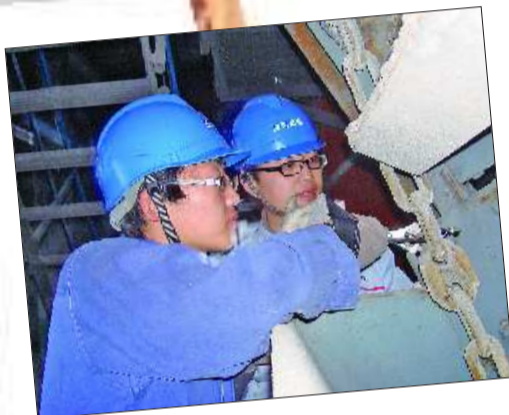
张炜(左)和师傅检修捞渣机。
