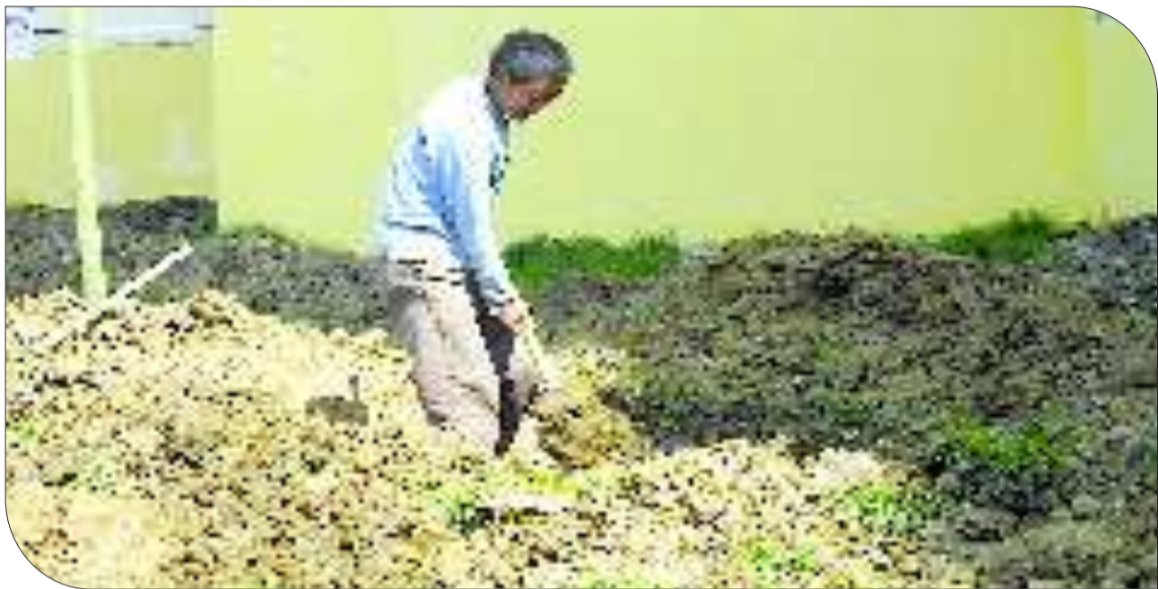
工人正在兰苗园进行主管道施工。 洪英 摄
