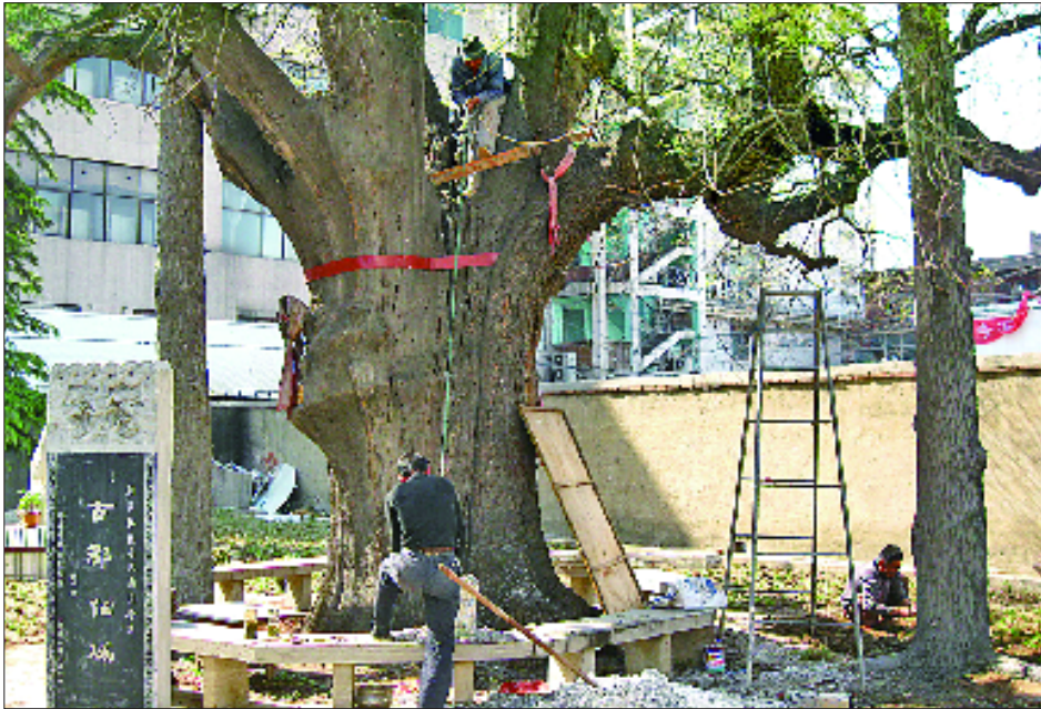
工作人员在往树内空洞填充防腐材料。 本报记者 刘守善 摄
