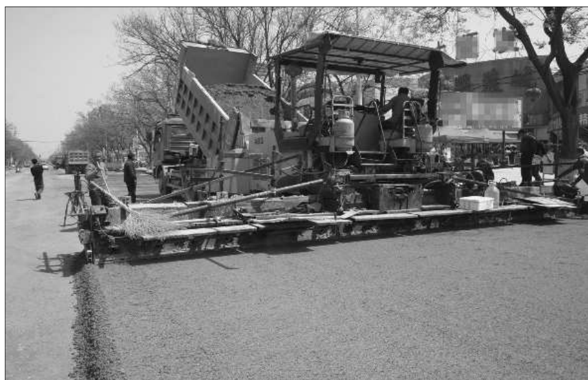
利民西路上,施工人员正在铺设18厘米厚的水泥稳定碎石层。
