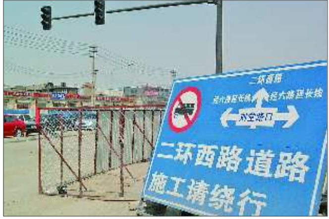
▲道路施工现场设有指示牌。
