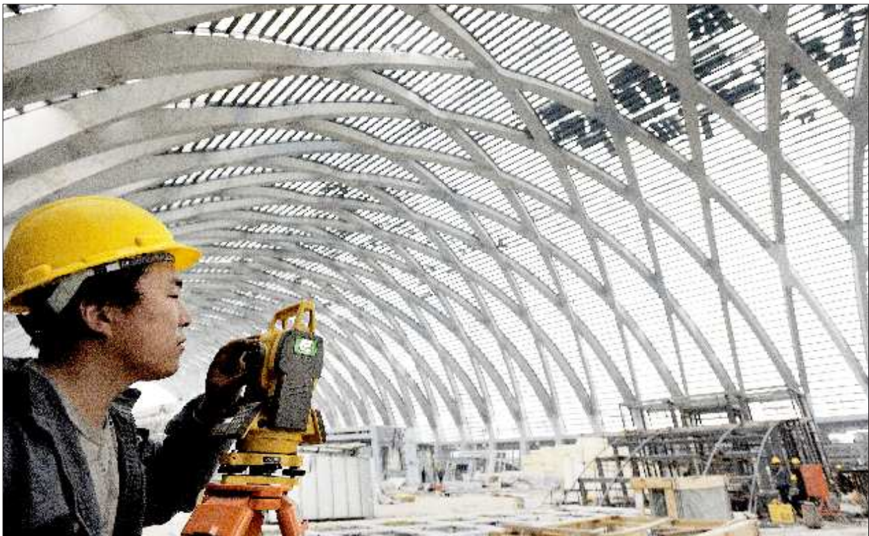
▲进入装修阶段的天津西站,图为天津西站的巨型钢架拱形结构。
